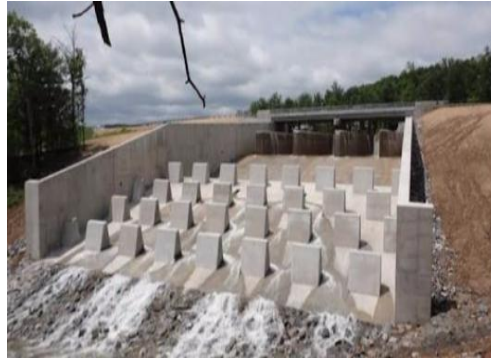
Gambar 7. Baffle Block bendungan (Sumber : Bendungan Kraftwerk Kembs Jerman)
