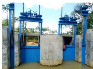
Gambar 5. Pintu Air (a) dan Stir Kemudi (b) Gearbox Double Sumber: CV. Ortega Sakti (2022)
