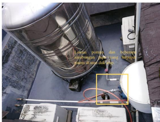
Gambar 3. Sistem perpipaan di dak atap
